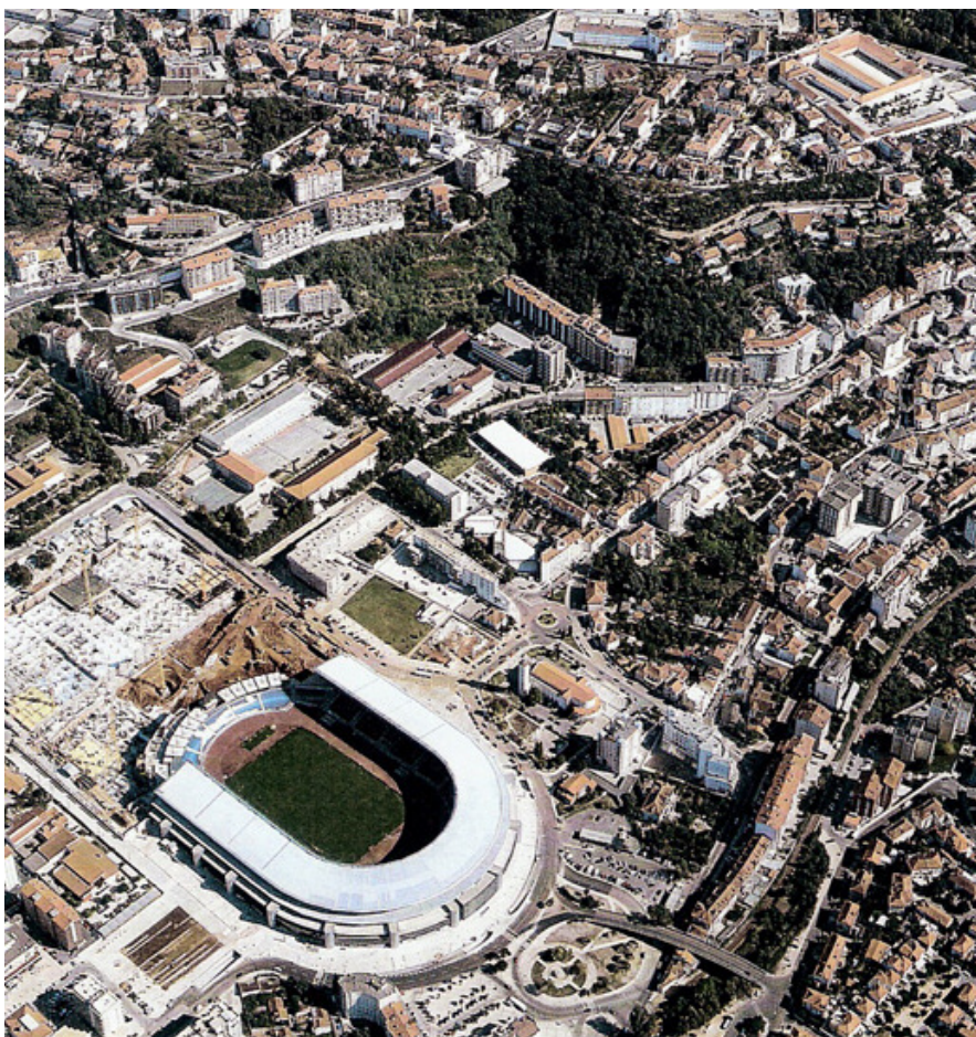
Figura 2 – Estádio de Coimbra Privatização de uma praça para construir um estádio e um centro comercial
